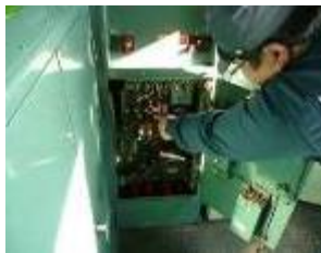
《KE65 機関車 室内点検訓練》
